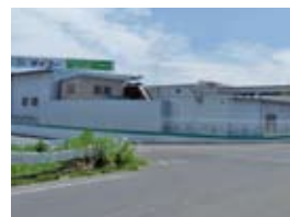
復旧した仙台港センター
